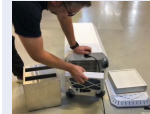
Suodatinten asennus perusmalliin
